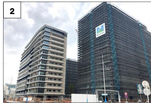
2 5-5 街区 地上躯体 くたい の整備状況
