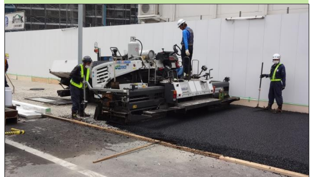
アスファルトフィニッシャーでアスファルトを敷きならしています。
