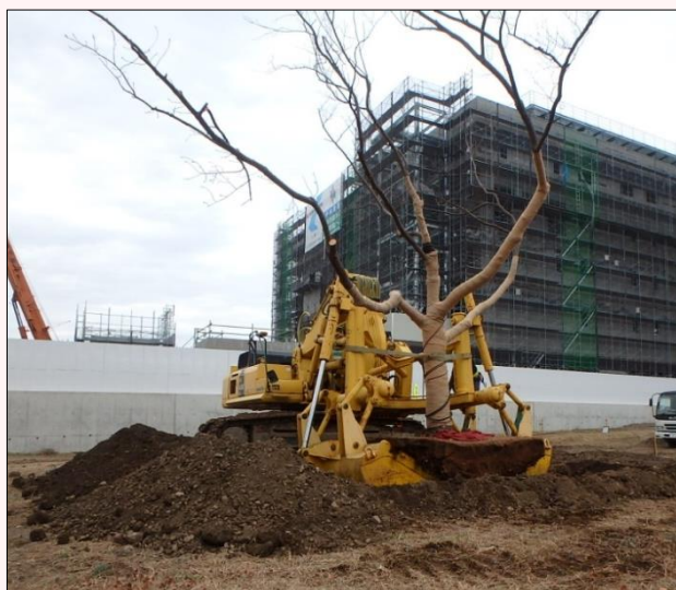
特殊な重機を用いた樹木の移植状況
