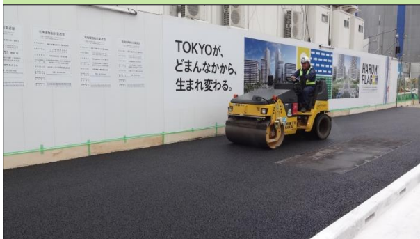
転圧ローラーでアスファルトを締め固めて、平らにしています。
