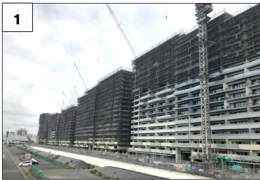
1 5-4 街区 地上躯体 くたい の整備状況
