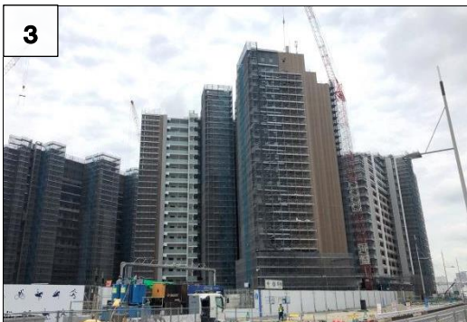
3 5-6 街区 地上躯体 くたい の整備状況
