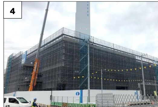
4 5-7 街区 地上躯体 くたい の整備状況
