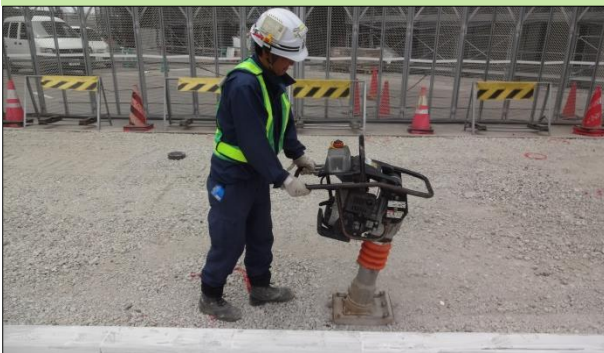
くだ 砕いた石を機械で叩いて締め固めています。
