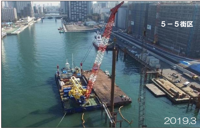
クレーン船で海上から杭を打ち込んでいます。
